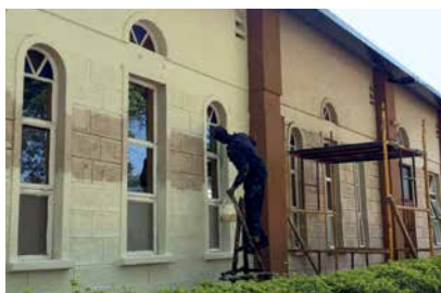
Kirchenbau des Priorats
